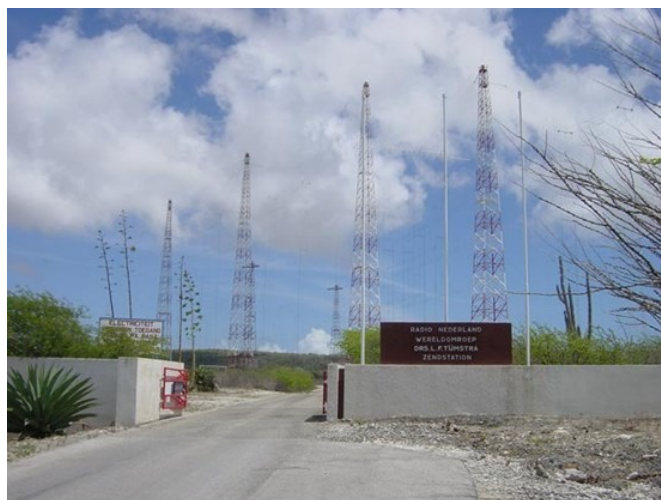
▲ Een aantal curtain antennas van Radio Nederland op Bonaire. Gain 21 dB t.o.v. een dipool(!)
