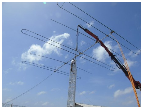
▼ Bert, PJ4KY boven in de mast bij het plaatsen van zijn DB42 MonstIR Pro Yagi Antenna, 40m-6m
