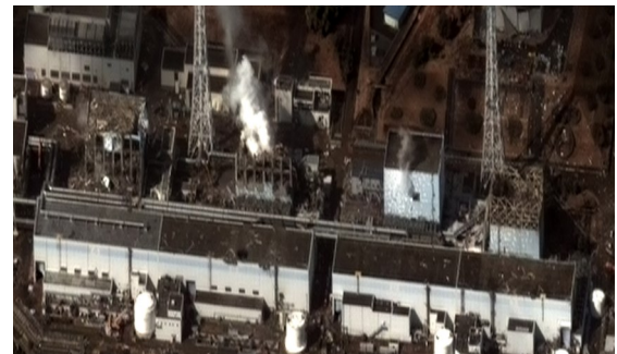
▲ Fukushima. De vier beschadigde reactorgebouwen (vlnr: Units 4, 3, 2 en 1) op 16 maart 2011. Explosies in Unit 1, 3 en 4 veroorzaakten onherstelbare schade. Foto: Wikipedia
