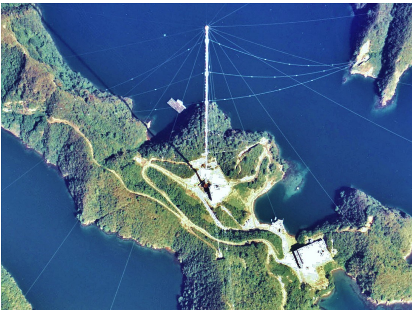
Afbeelding 7: Luchtfoto van de Shushi-Wan zendantenne (station H, Japan) voor het Omega-navigatiesysteem, dat in de VLF-band uitzond op 10 - 14 kHz. De antenne, gelegen nabij Shushi-Wan op het eiland Tsushima, was een paraplu-antenne die bestond uit een 389 meter hoge stalen buismast, geïsoleerd tegen aarde, met 14 draden die zich diagonaal uitstrekten van de bovenkant naar de grond. Deze mast, die in 1973 werd gebouwd en de hoogste constructie in Japan was (en misschien wel de hoogste stalen buismast ooit gebouwd), werd in 1998 ontmanteld.
