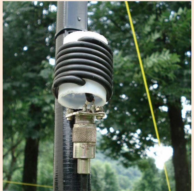
De onderkant van de J-pole voor 50 MHz met mantelstroomfilter.
