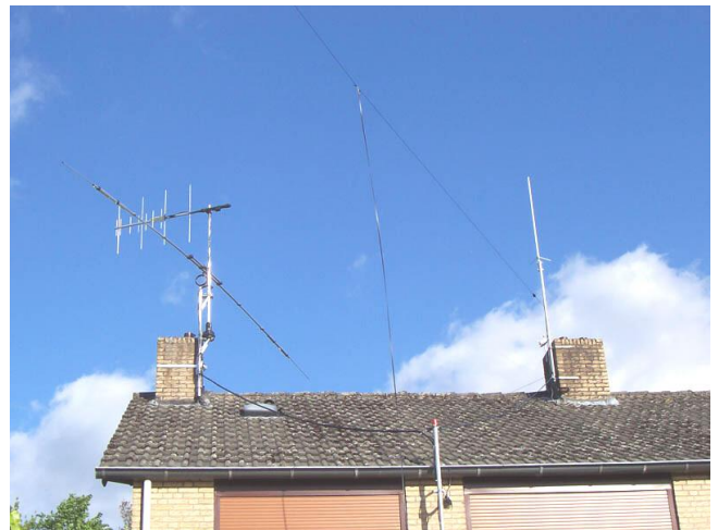
De antenne-opstelling met de korte ZS6BKW van PD5B (van de rechter schoorsteen naar midden-boven).
