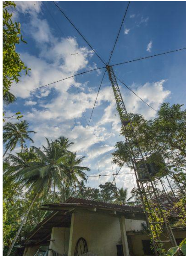
Het huis van 4S7AB en zijn antennepark. Op de voorgrond een mast met bovenin een eigenbouw Hexbeam voor 40 en 30 meter.
