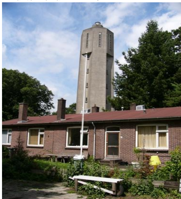
Watertoren met VHF antennes van PI4VRZ/A
