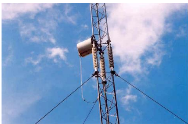
Afbeelding 7, verlengspoel van de voormalige locator PH, foto collectie Jeroen Hoppenbrouwers
