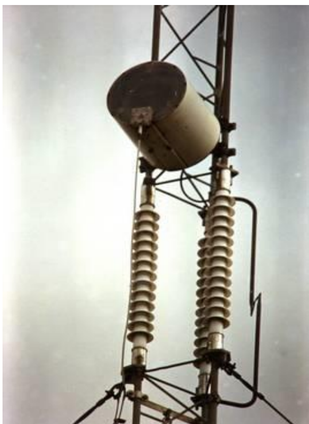
Afbeelding 8, verlengspoel van het NDB STD, foto collectie Wim van Beek/Johan Veldhuis, let ook op de vonkbrug
