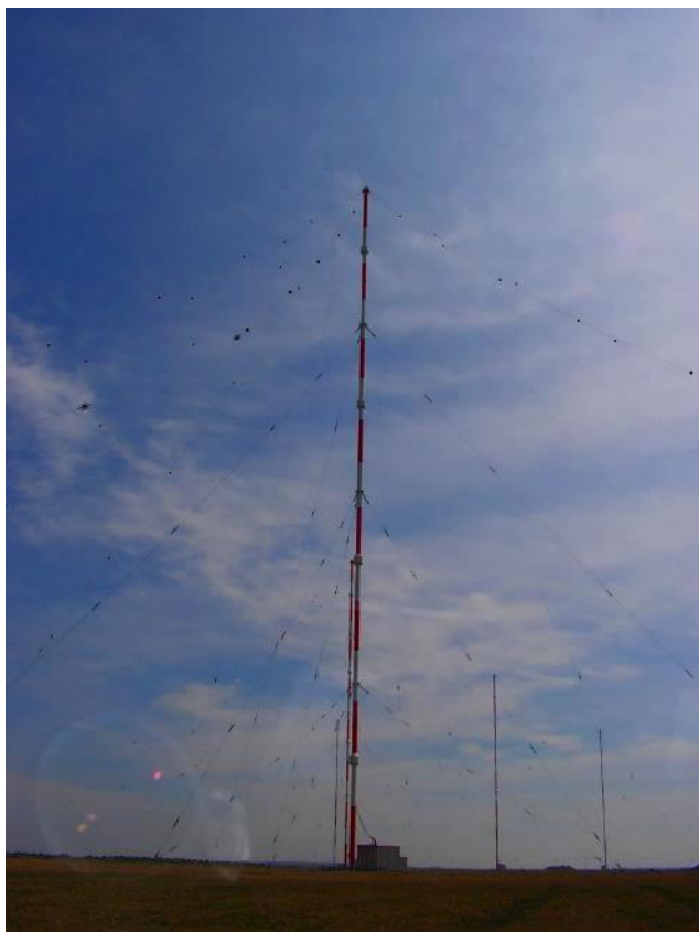
Afbeelding 13: Antenne masten en zendergebouw (GNU licentie)
