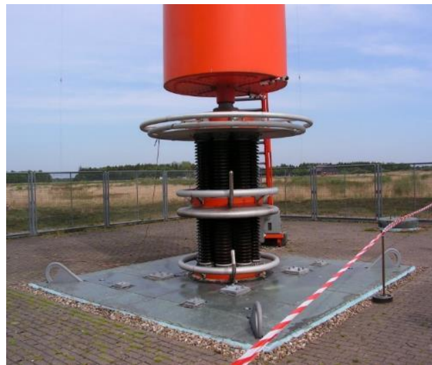
Afbeelding 14: Voetisolator DHO38 (GNU licentie)
