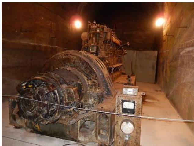
Afbeelding 7. Eén van de vier dieselaggregaten.
