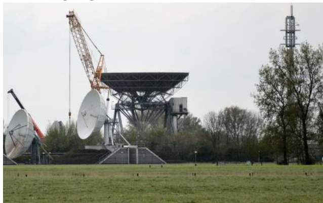
Afbeelding 6, Sloop BRM-1 , 4 mei 2017. Verwijderen schotelsegmenten. Schotel In zenith stand.
