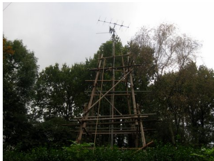
De gepioneerde toren met als antennes een kruisyagi voor 2 meter, een yagi voor 2300MHz en een schotel voor 10GHz.
