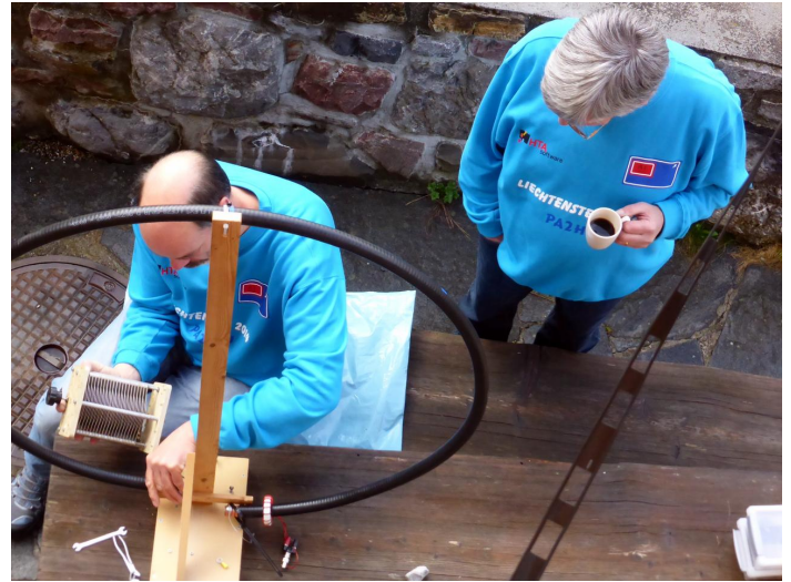
Montage van een afstem-C met grote plaatafstand aan de loop. De spanningen kunnen tot kiloVolts oplopen!
