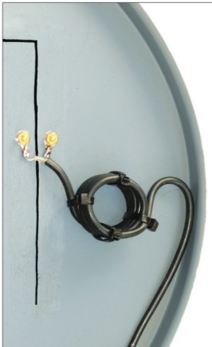
Figuur 6. De Coax voedingskabel voorziet meteen in een mantelstroomspoel met 6 windingen direct bij de voedingsaansluiting.
