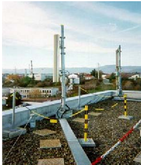
Figuur 14 Een afgezette veiligheidszone rond een antenne op een dak (overgenomen uit Casavola et al. [111]).
